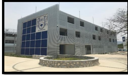
Edificio G de Laboratorios. En la planta baja se localiza en la mitad izquierda el Laboratorio de Sistemas Dinámicos y Complejidad.
