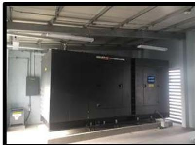
Generadores auxiliares que proporcionan suministro de energía de tal forma que el laboratorio solamente pueda parar 1.6 horas al año.
