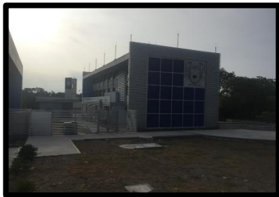
Edificio que Alberga LARCAD con el detalle de la instalación eléctrica de 1MW redundante
